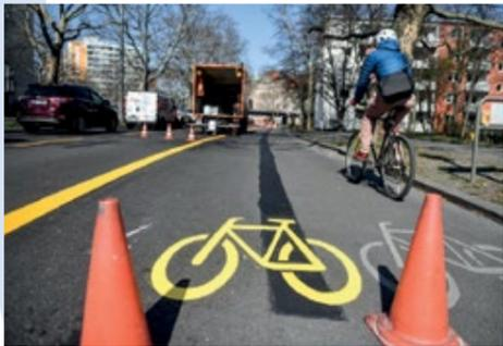
La **Rete Ciclabile d'emergenza RME** è una rete di corsie per la mobilità smart. Può essere realizzata direttamente sulle carreggiate stradali, con modifiche provvisorie ed integrazioni alla segnaletica orizzontale (ridisegnando le strisce) e verticale ed, in alcuni casi, con l'ausilio di delimitatori di carreggiata o elementi di arredo.
